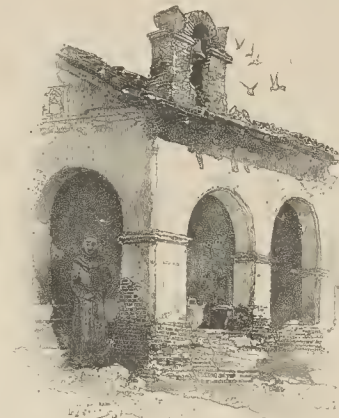
Claustro y campanario de la Misión de San Fernando
